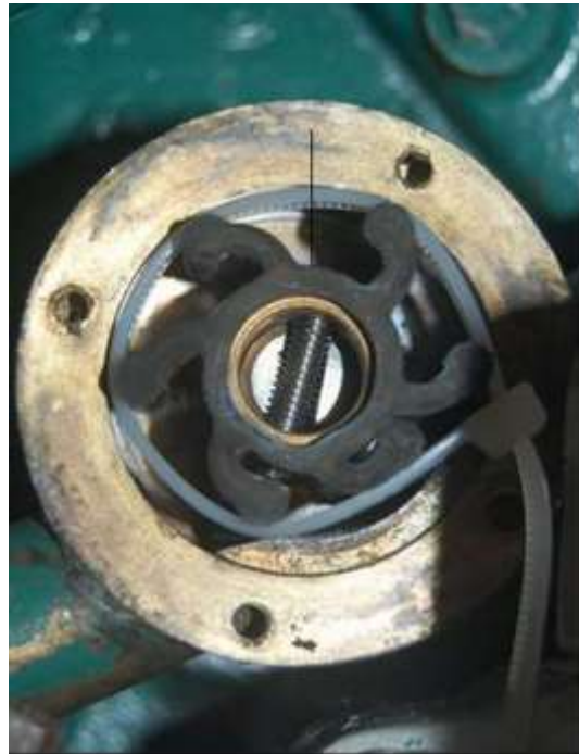
Impellor aanbrengen met behulp van tiewrap...
