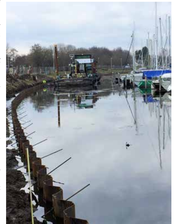
"Het werk aan de damwand.."
