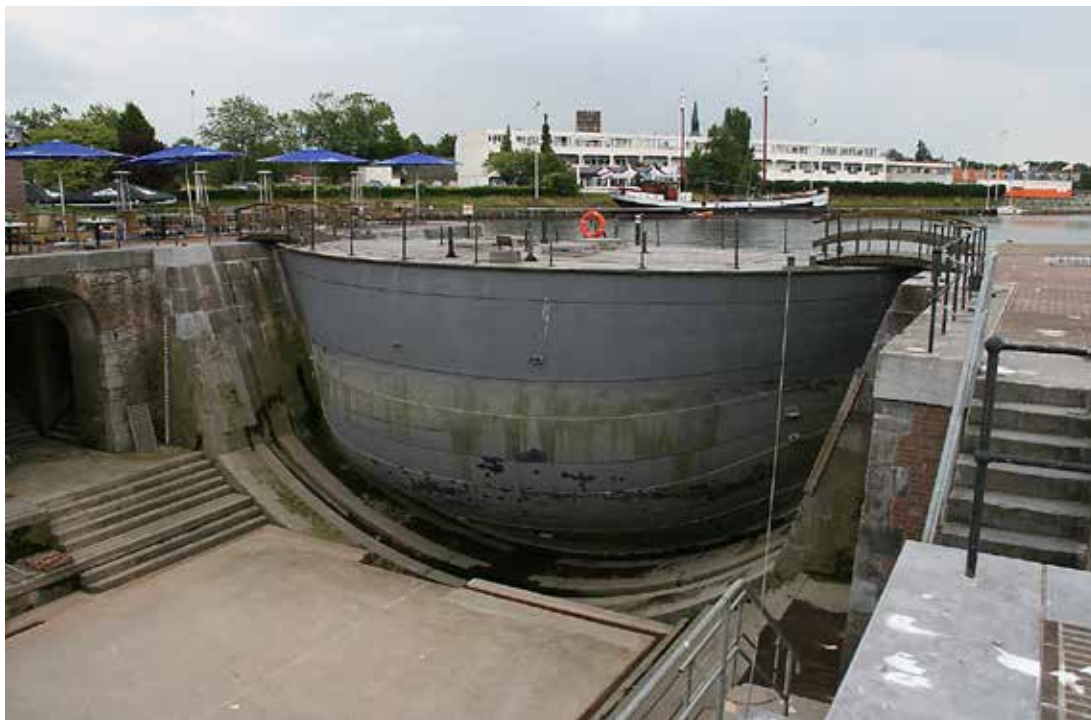
'De bootdeur wordt weggevoerd als de toegang open moet..'
