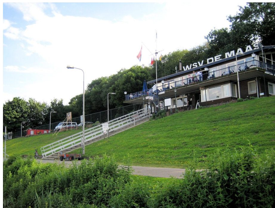
Havenkantoor, restaurant en enorme aluminium loopbruggen.
