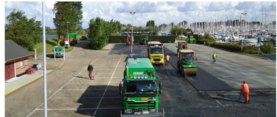
Het asfalteren in volle gang
