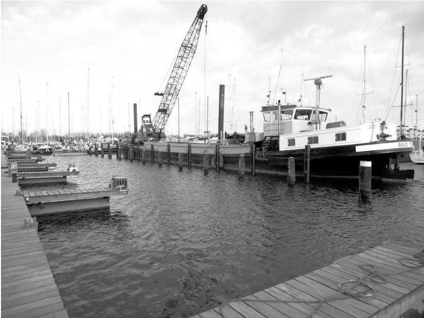
Het kraanschip en alle nieuwe stalen palen. De houten palen moeten op het moment dat deze foto is genomen nog getrokken worden.
