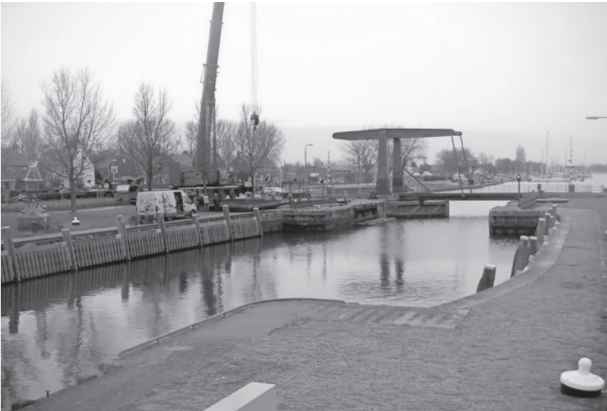
Net te laat om de sluisdeur in de kraan te zien hangen!
