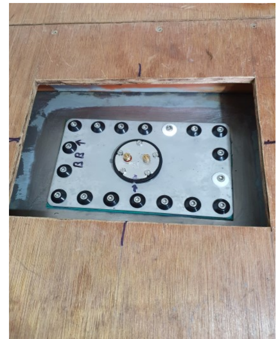
Het inspectieluik gemonteerd...
